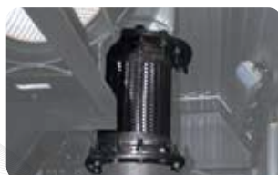
Гибкий переходник выхлопной системы
