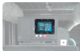
Панель управления для параллельной работы
