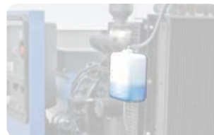
Расширительный бачок системы охлаждения
